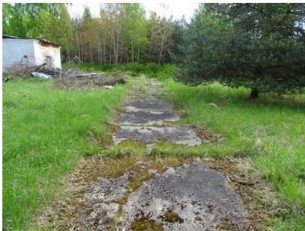
foto znalce 21.5.2021, východní část pozemku
