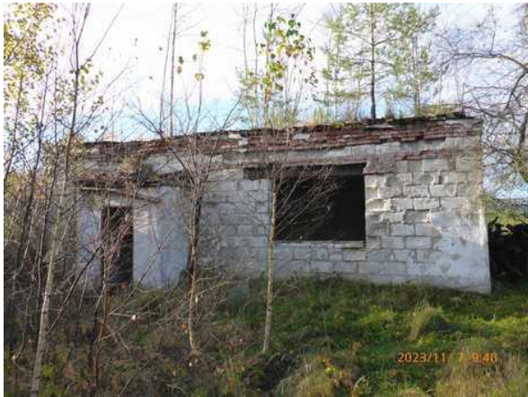
budova na p.č. 97
