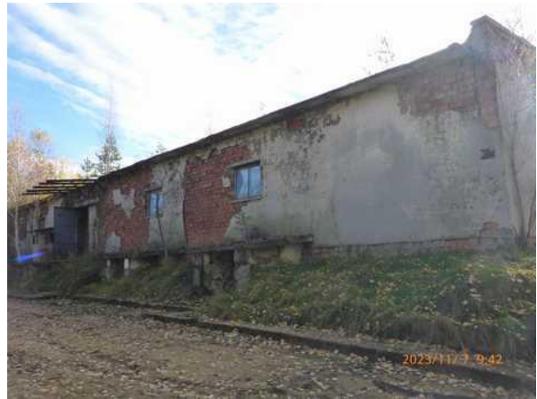
budova na p,č 98
