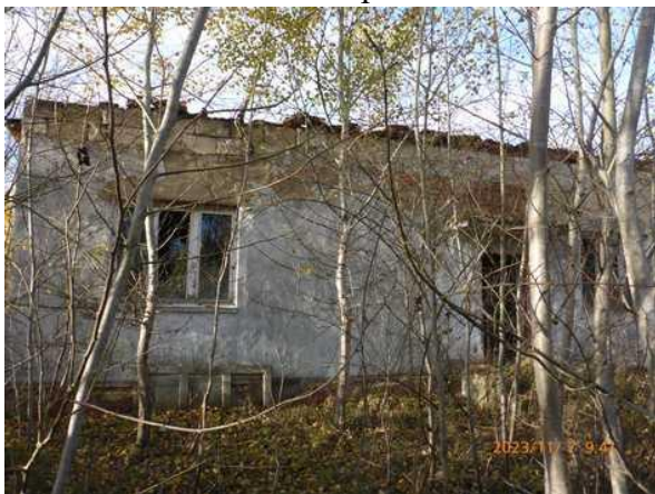
budova na p.č. 96
