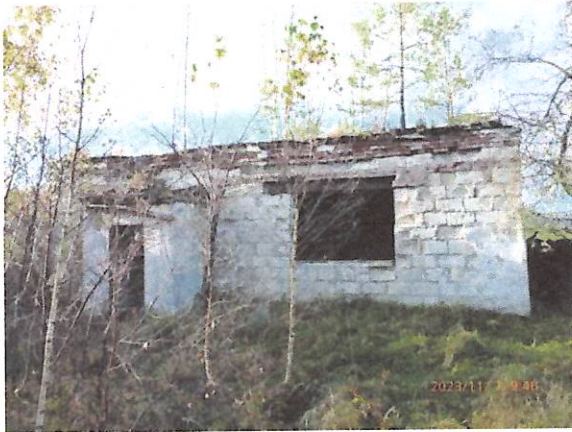
budova na p.č. 97
