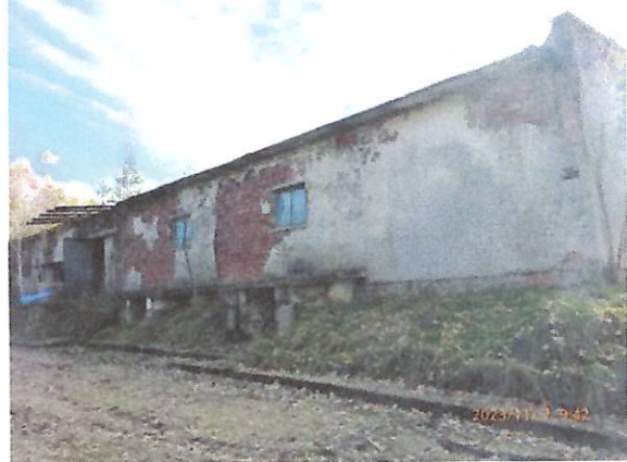
budova na p.č 98
