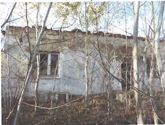
budova na p.č. 96
