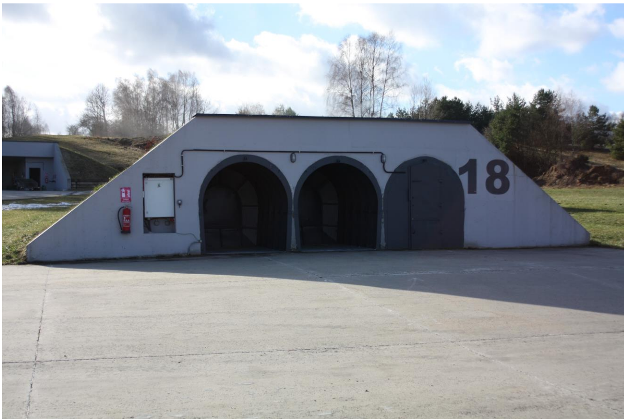
Obrázek 15 Pohled na budovu 18
