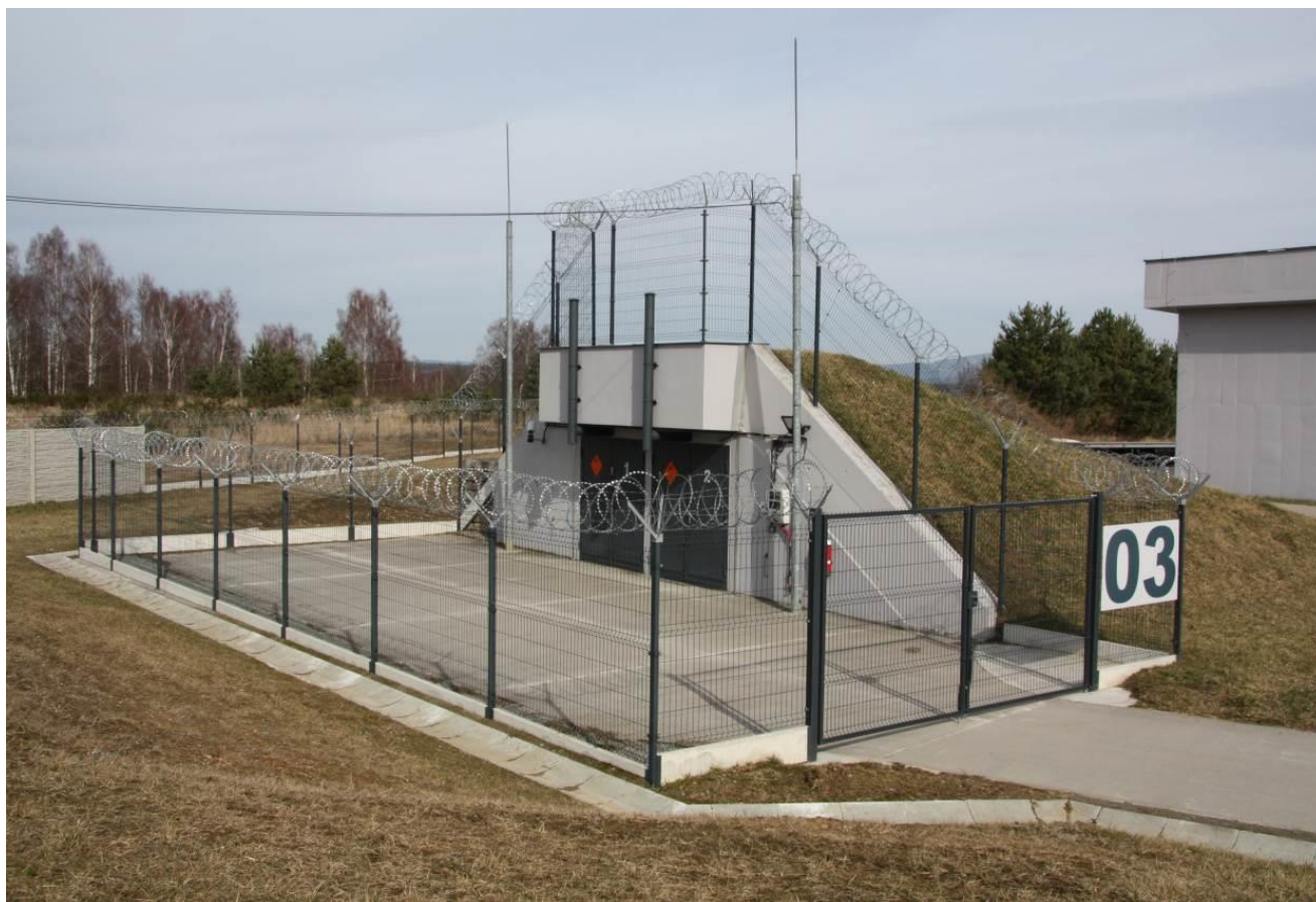
Obrázek 6 Pohled na budovu 03
