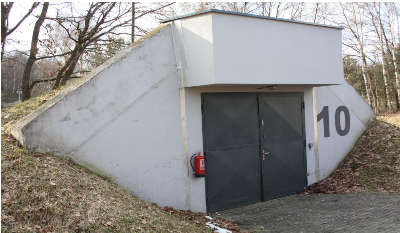
Obrázek 13 Pohled na budovu 10
