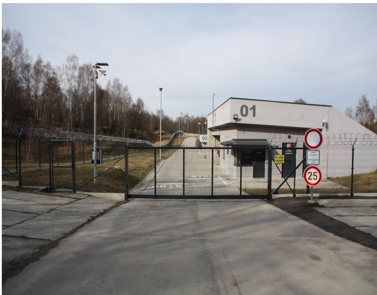
Obrázek 4 Čelní pohled na budovu 01 a vjezdovou bránu
