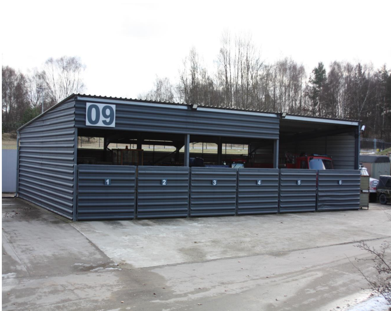
Obrázek 12 Pohled na budovu 09
