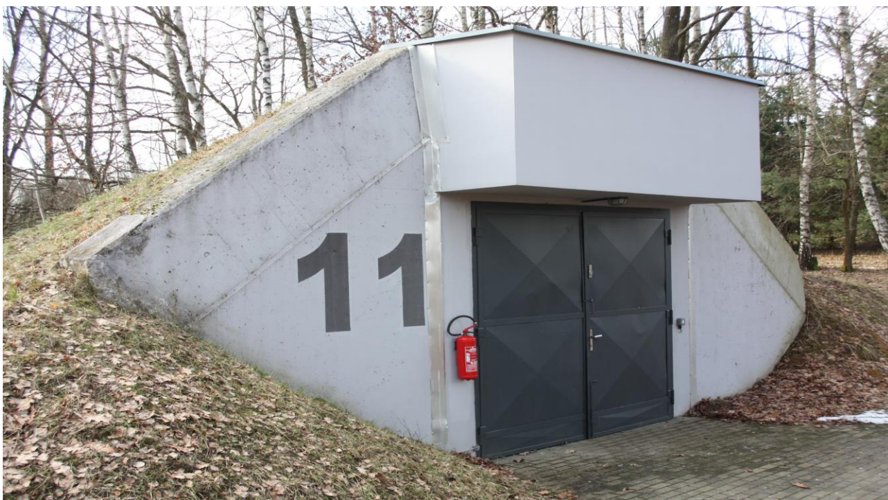
Obrázek 14 Pohled na budovu 11
