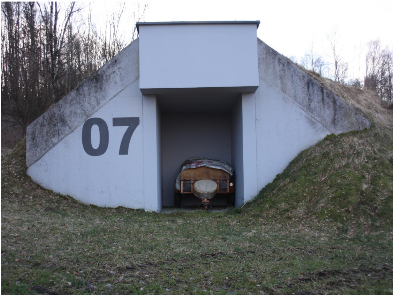
Obrázek 10 Pohled na budovu 07
