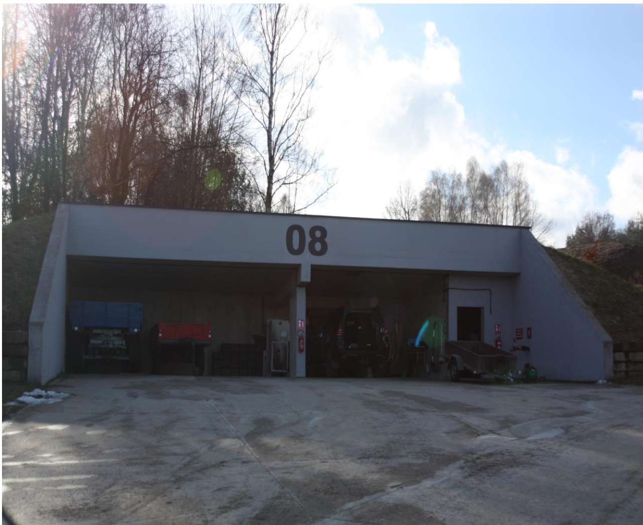
Obrázek 11 Pohled na budovu 08
