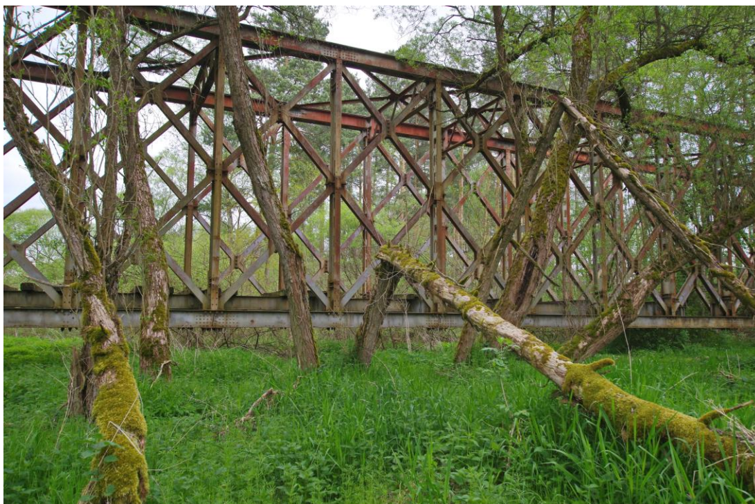
16. (meandry_16.jpg; Richard Višňák; 13. 5. 2023; PP Meandry Ploučnice u Mimoně) Dožívající vrby křehké ( Salix euxina ) s dosloužilým skeletem železničního mostu.
