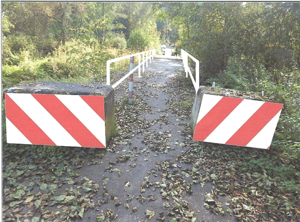
Pohled na komunikaci ve směru k Hradčanům s DIO
