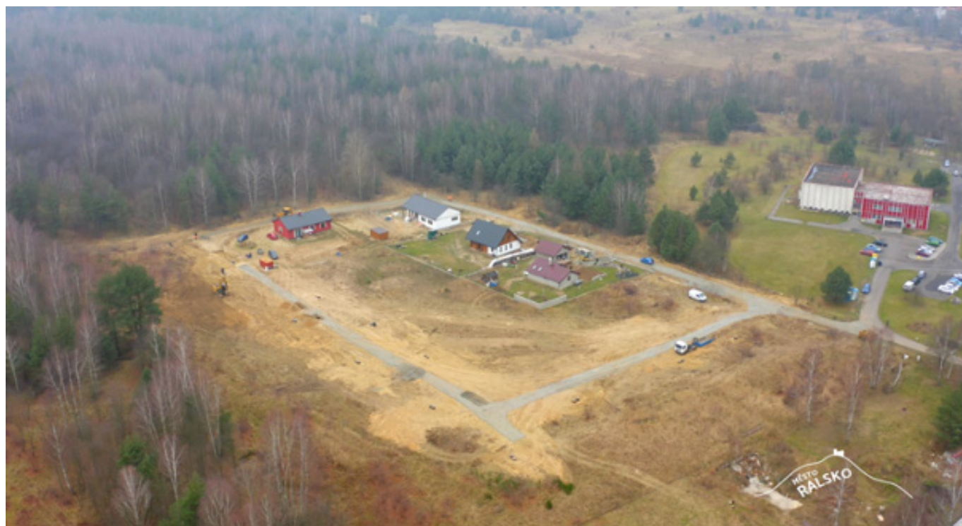
Pohled na lokalitu s nově vzniklými stavebními parcelami
