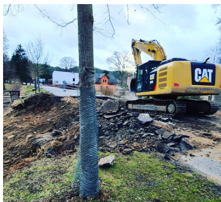
Stavební práce na hrázi Hradčanského rybníka
