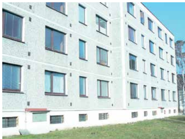
Zateplení panelového domu na Ploužnici
