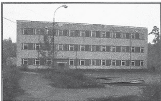
Výrobně-skladovací budova, 3NP, halové prostory Zastavěná plocha 726 m 2 , cena k jednání: 1.900.000,-Kč,
